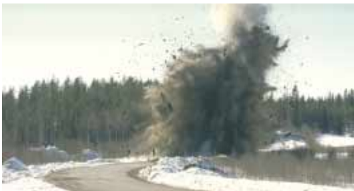
Sprängning av vägbank
