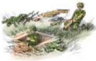
Ståvärn grävs och virke till täckning läggs ut
