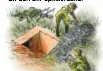
Täckningen förstärks så att den blir splittersäker
