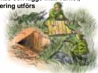
Bröstvärn utformas, en lätt lucka tillverkas och läggs intill värnet, maskering utförs
